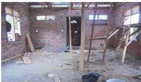
Gambar 1. Kondisi Pembangunan di Desa Naga Saribu
